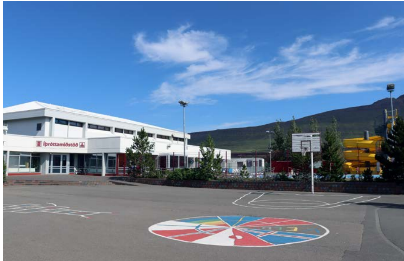
Annar tveggja miðpunkta íþróttastarfs Samherja, íþróttamiðstöð Eyjafjarðarsveitar á Hrafnagili. Íþróttahúsið til vinstri og sundlaugin til hægri.
